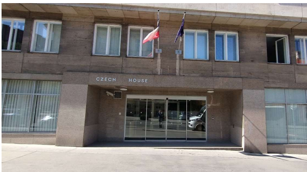
Vstup do budovy
